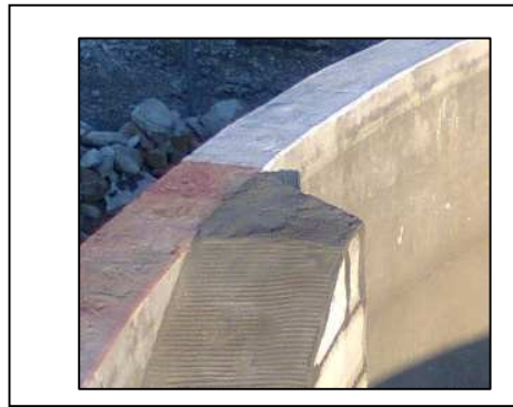
Imatge 9: Detall superfície rugosa i exemple de rampa doble adossada a la paret
