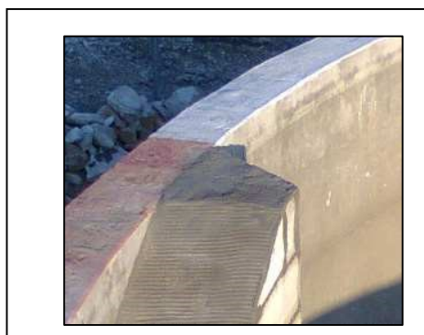
Imatge 11: Detall superfície rugosa i exemple de rampa simple adossada a la paret
